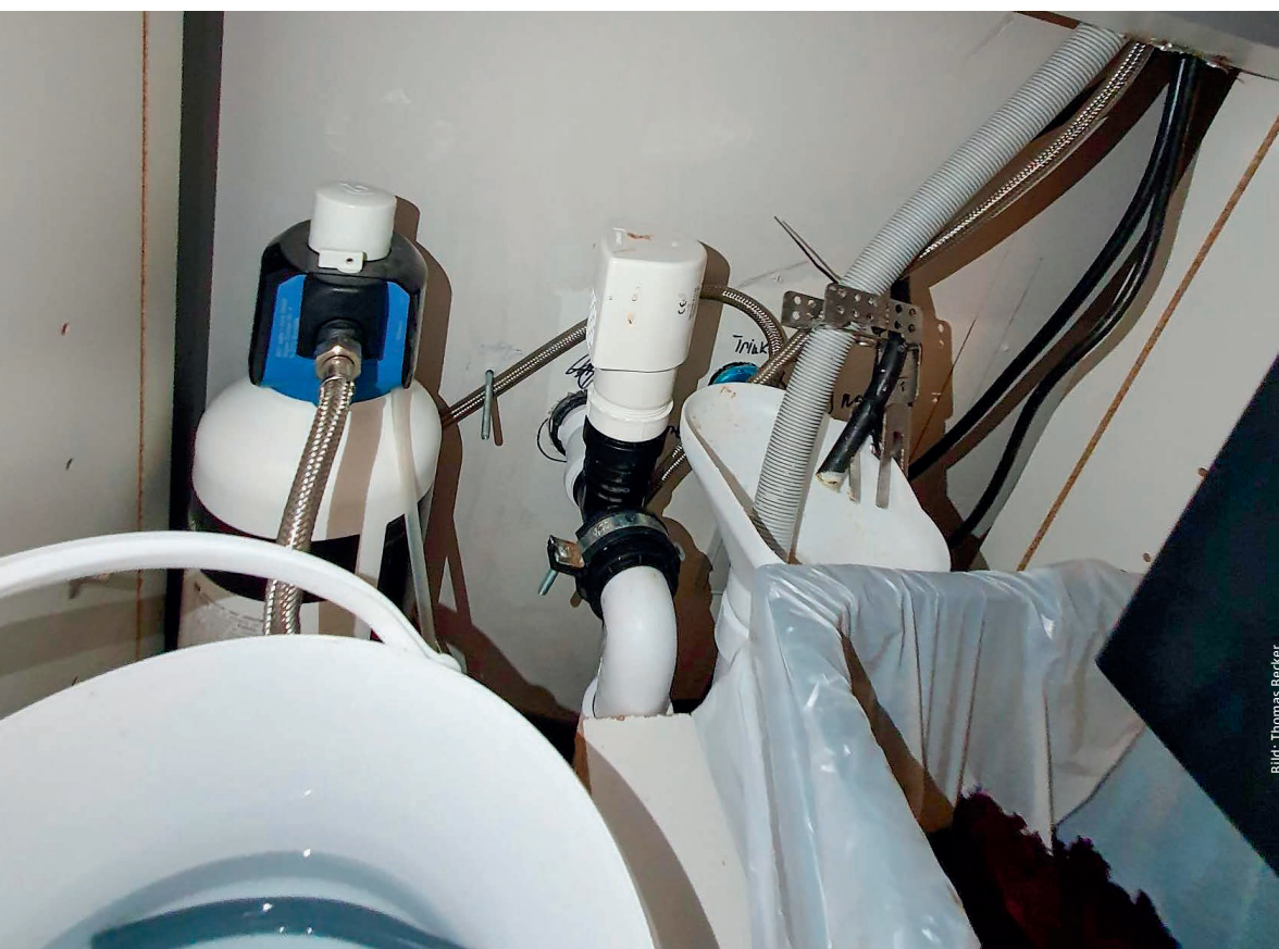
Teeküche: Spülen-Unterschrank mit Rohrbelüfter DN 50.
