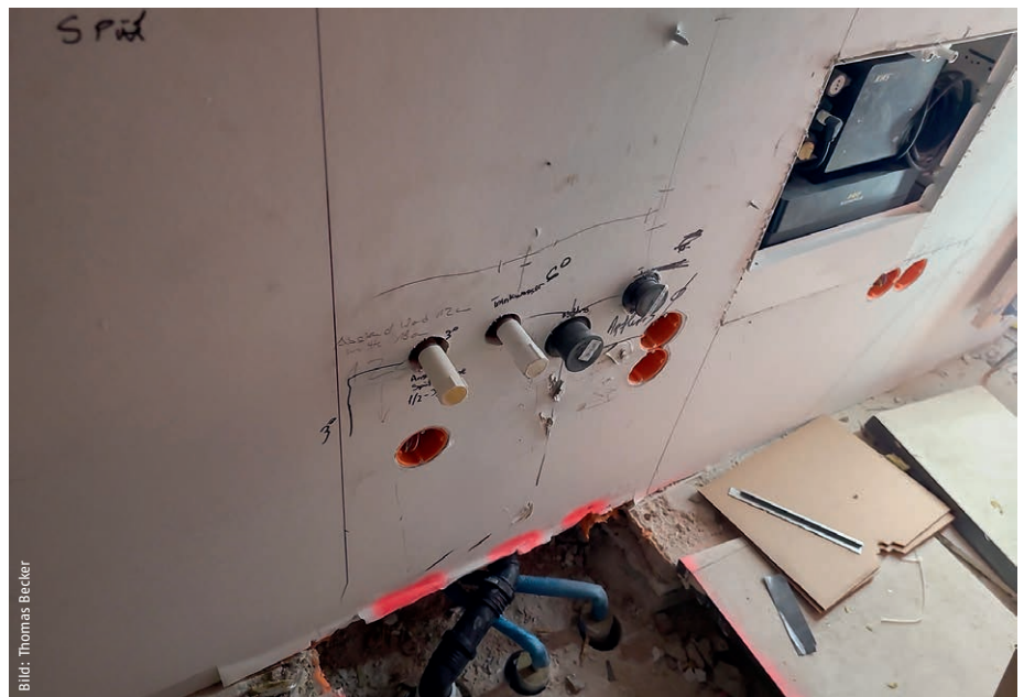
Geöffnete Vorwandinstallation in der Teeküche.
