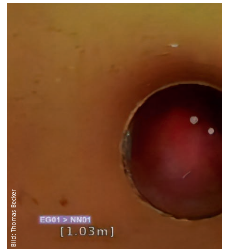
Abfluss am SML-Übergang. Die Dichtung ragt ins Rohr.
